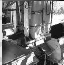
Załadunek pociągów – wagi zbiornikowe i kolejowe
